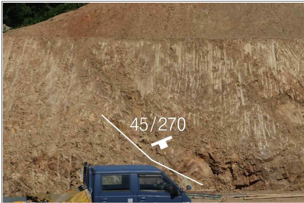
【그림 10】 A 영역에 발달한 불연속면
