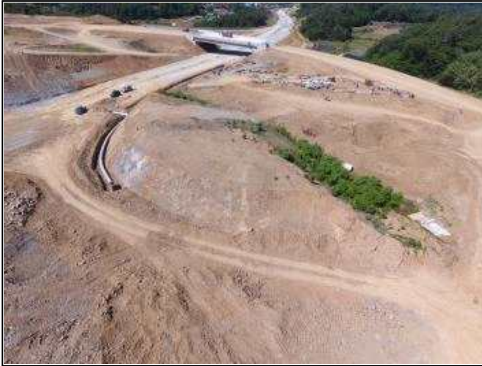
【그림 3】 깎기비탈면 시점부 측면 사진
