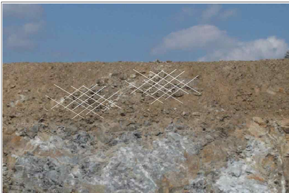
【그림 16】 B 영역 상세사진 (세편화된 암석)
