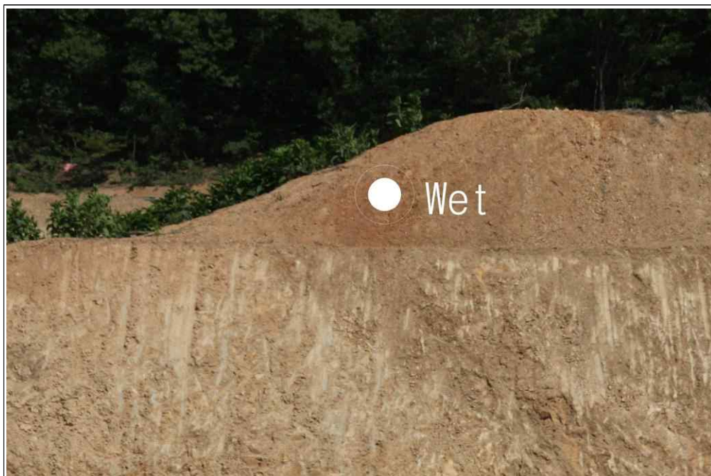
【그림 11】 A 영역 상세사진 (지하수 유출)
