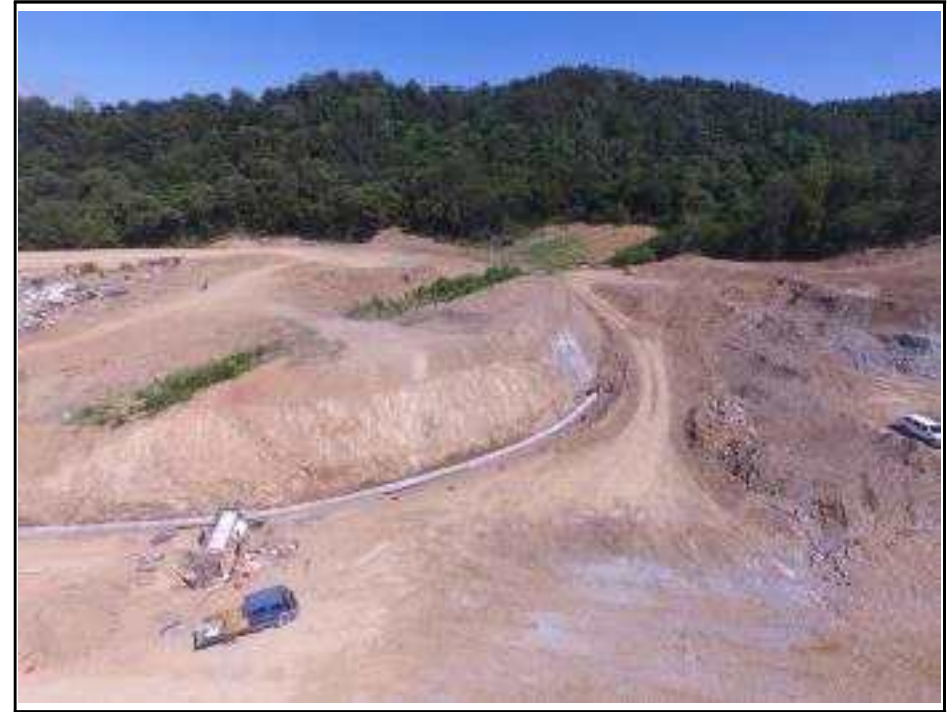
【그림 4】 깎기비탈면 종점부 측면 사진
